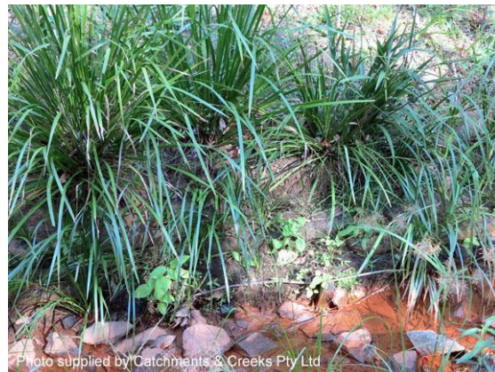
Toe stabilisation (May 2013)
