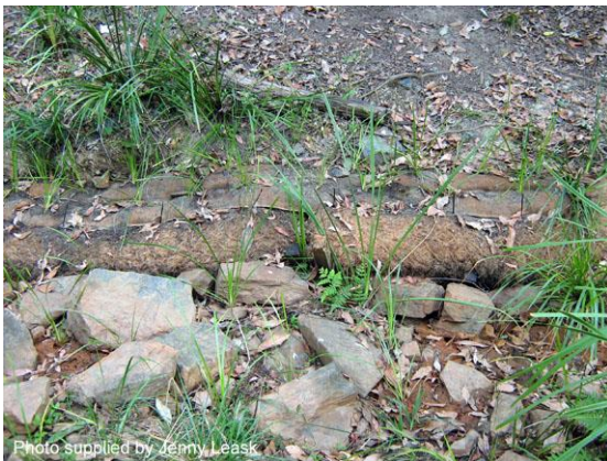
Toe stabilisation (Sept 2012)
