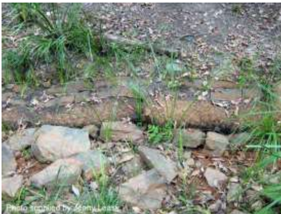
Toe stabilisation (Sept 2012)
