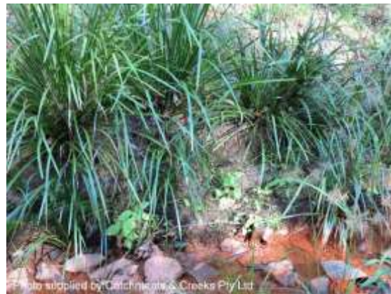
Toe stabilisation (May 2013)
