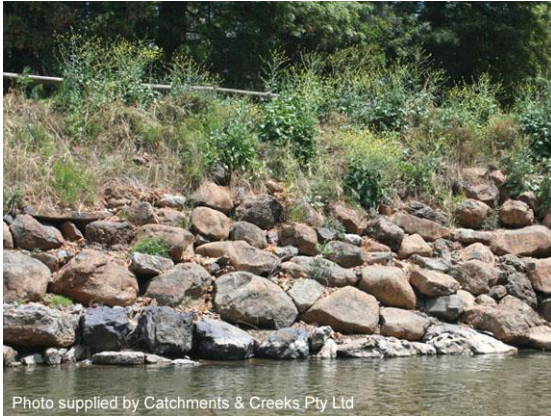
Bank stabilisation (NSW)
