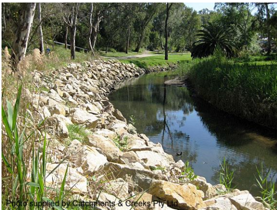
Bank stabilisation (SA)
