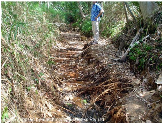
Creek bed scour (Qld)
