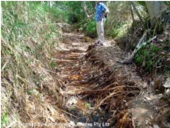
Creek bed scour (Qld)
