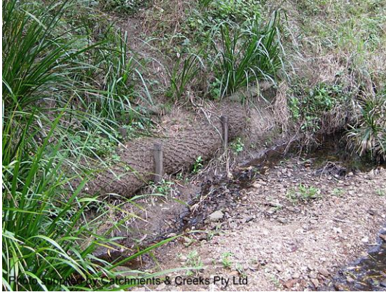
Geo log toe protection (Qld)
