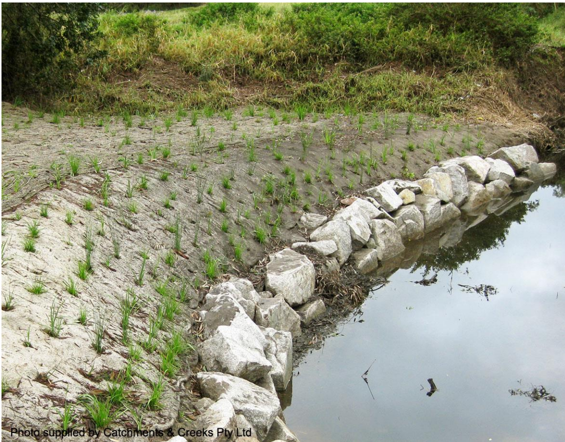
Toe stabilisation using rock (Qld)
