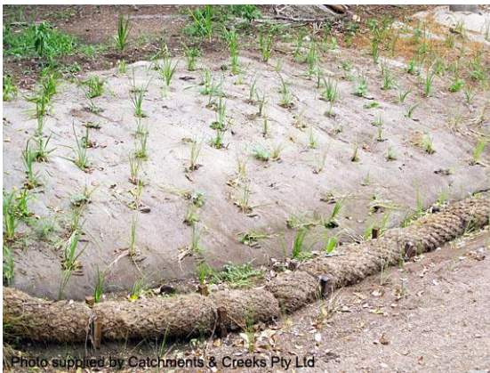
Geo log toe protection (Qld)
