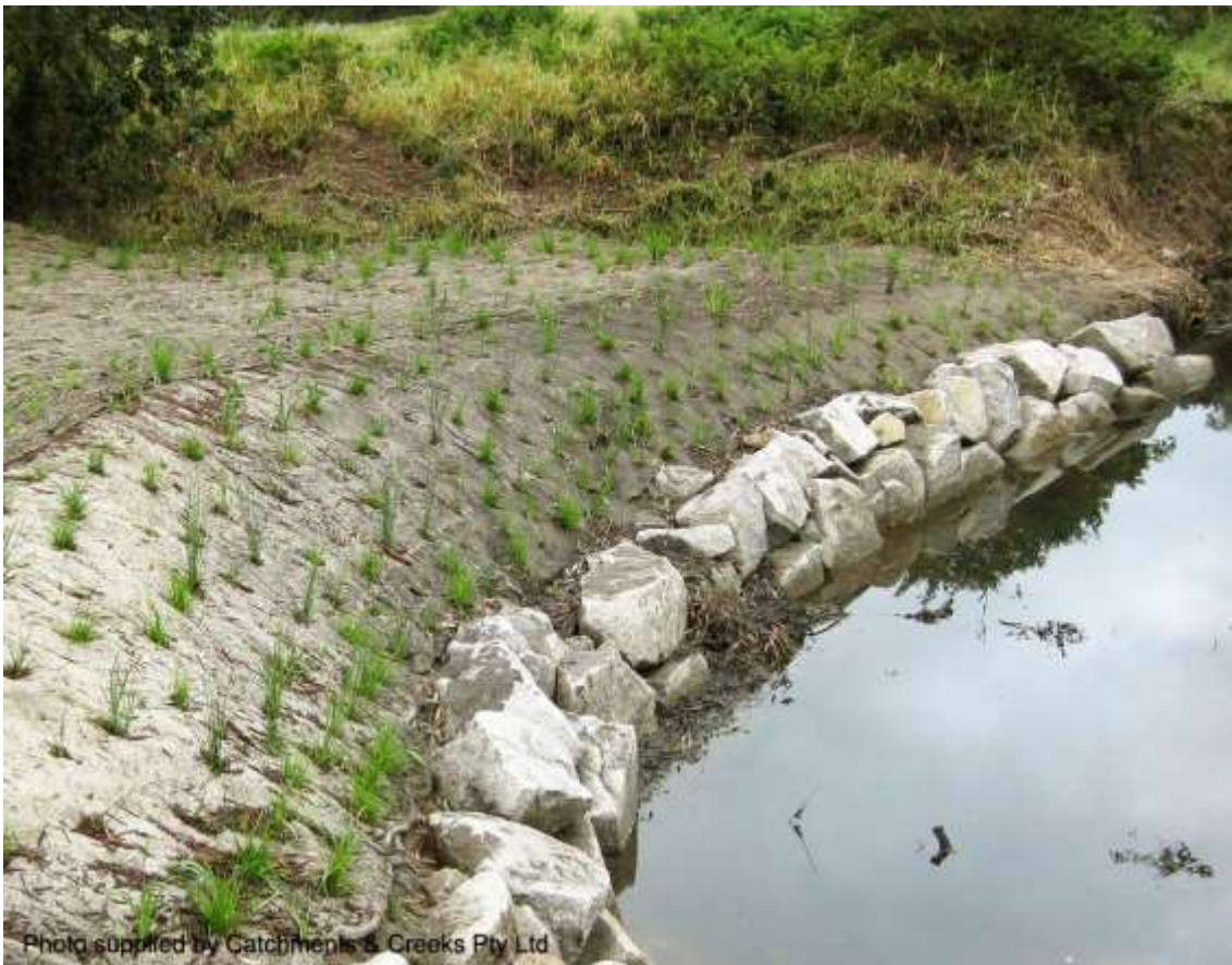
Toe stabilisation using rock (Qld)
