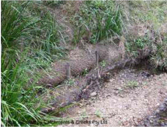
Geo log toe protection (Qld)
