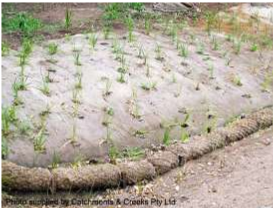
Geo log toe protection (Qld)
