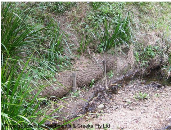
Geo log toe protection (Qld)
