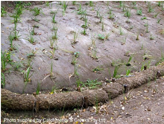
Geo log toe protection (Qld)
