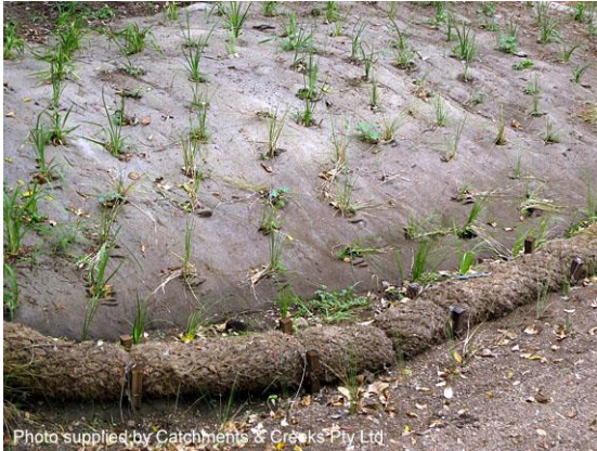
Geo log toe protection (Qld)
