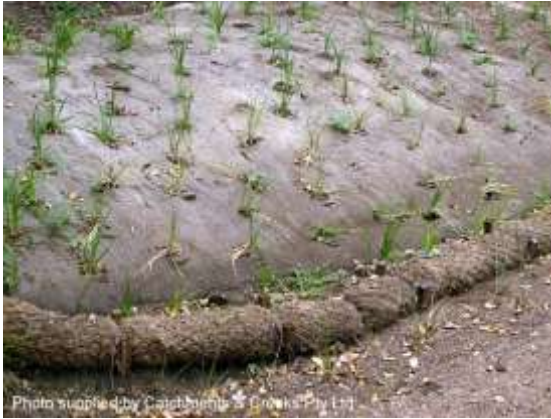
Geo log toe protection (Qld)
