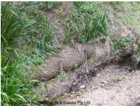
Geo log toe protection (Qld)
