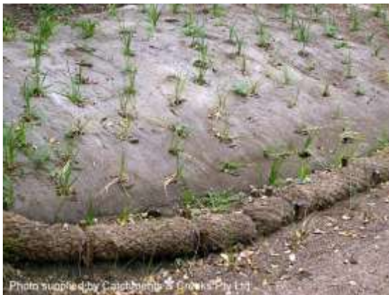
Geo log toe protection (Qld)
