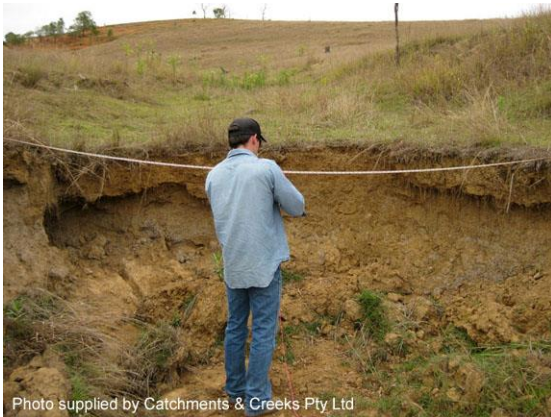
Site inspection (Qld)
