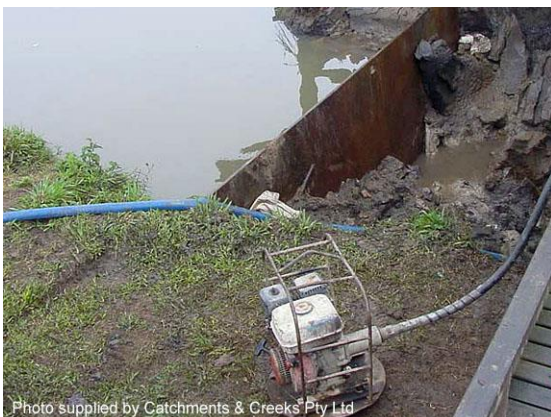
Site de-watering (Qld)
