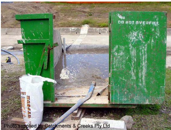
Modified mini skip settling tank (Qld)
