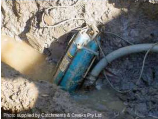
Site de-watering (Qld)
