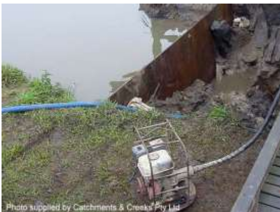
Site de-watering (QLD)
