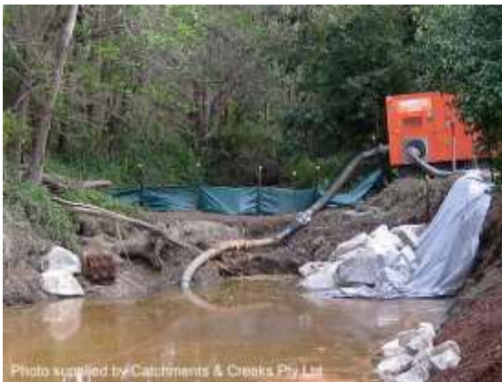
Site de-watering (Qld)
