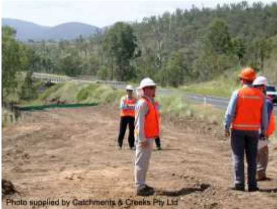
Site inspection (Qld)
