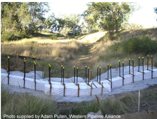
Modular sediment trap
