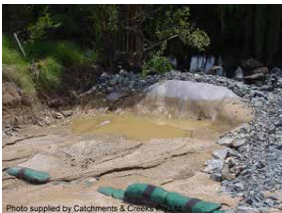
Type 2 sediment trap
