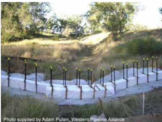
Modular sediment trap
