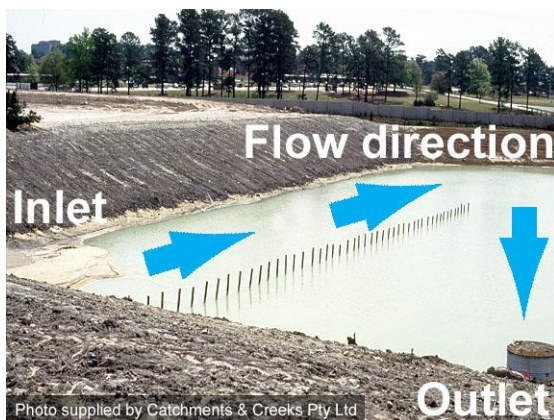
Internal baffle (USA)
