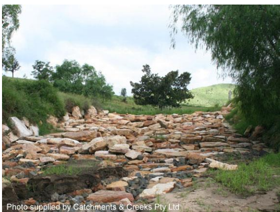
Rock chute (Qld)
