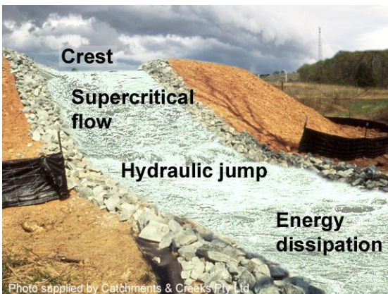
Sediment basin spillway (USA)
