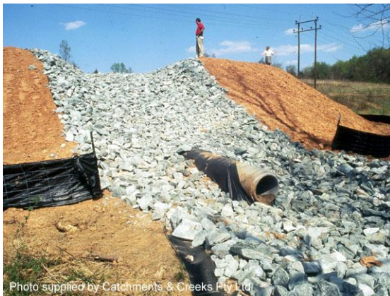
Embankment spillway (USA)
