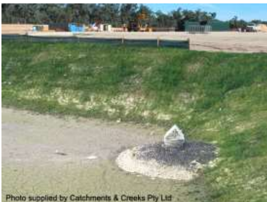
Riser pipe outlet (NSW)
