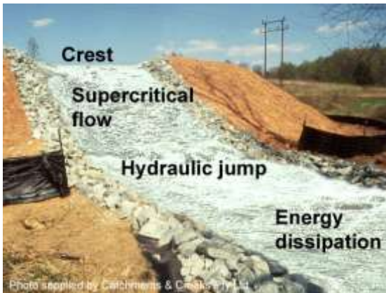
Sediment basin spillway (USA)
