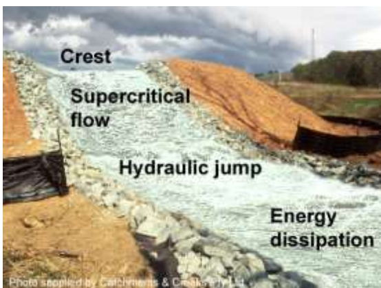
Sediment basin spillway (USA)
