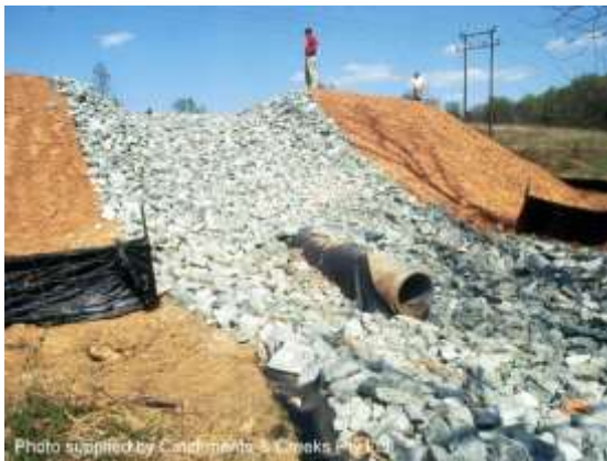
Embankment spillway (USA)
