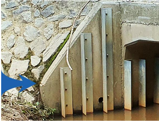
Wingwall baffles (Qld)
