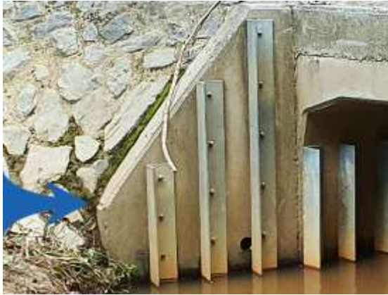
Wingwall baffles (Qld)
