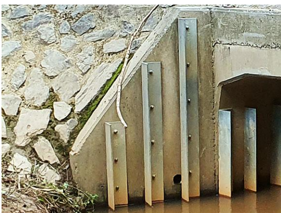
Wingwall baffles (Qld)
