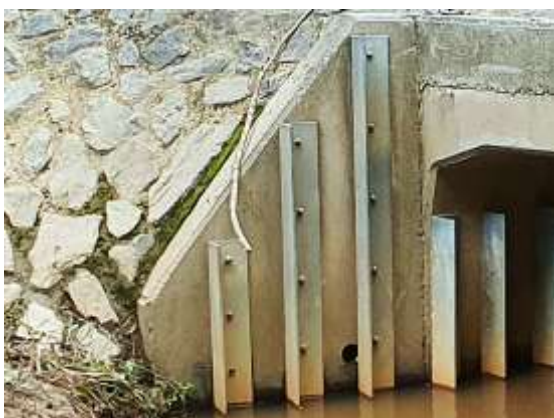
Wingwall baffles (Qld)
