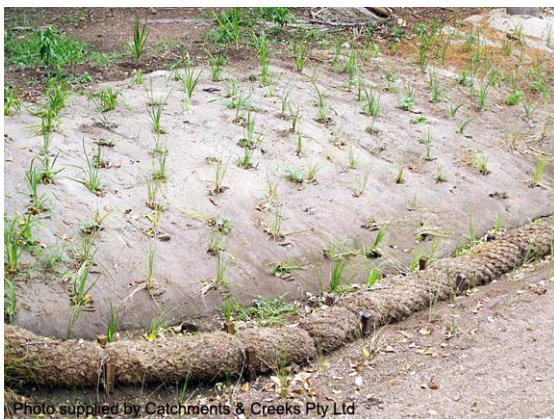
Geo log toe protection (Qld)
