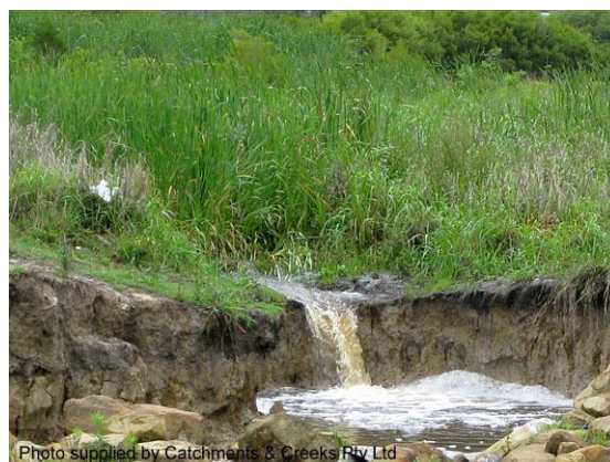
Erosion on the edge of an lake (NSW)
