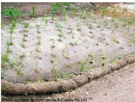
Geo log toe protection (Qld)
