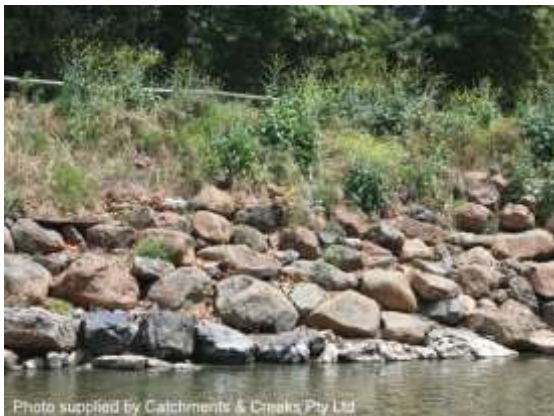
Bank stabilisation (NSW)
