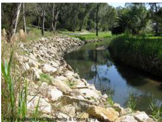
Bank stabilisation (SA)
