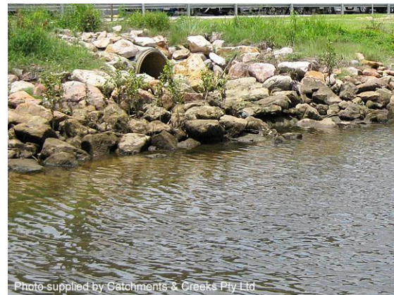
No headwall (Qld)
