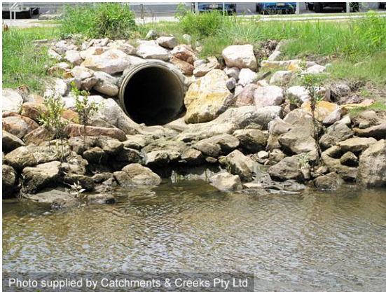
No headwall (Qld)
