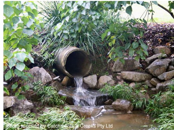
No headwall (Qld)
