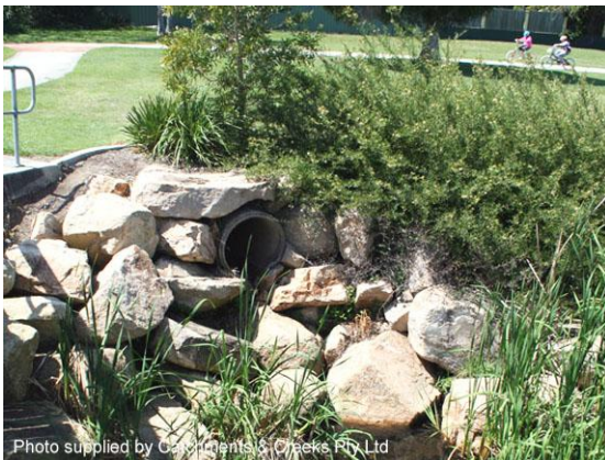
No headwall (Qld)
