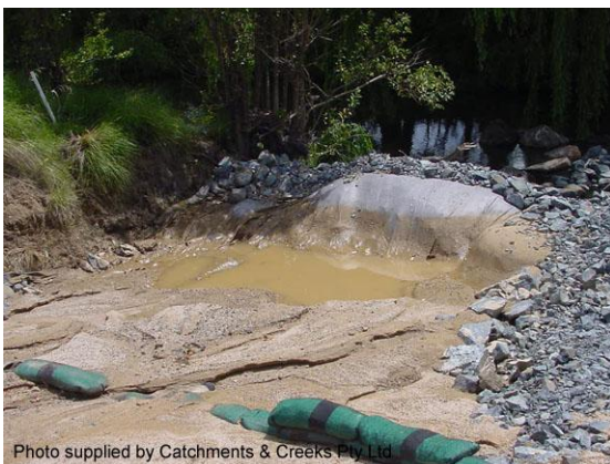
Type 2 sediment trap
