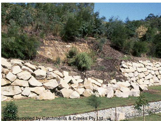
Failure of earth batter (landslip)
