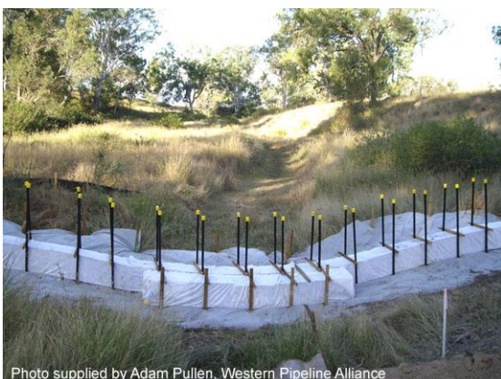
Modular sediment trap
