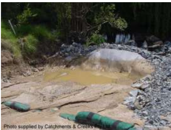
Type 2 sediment trap
