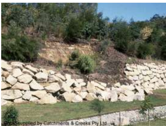
Failure of earth batter (landslip)
