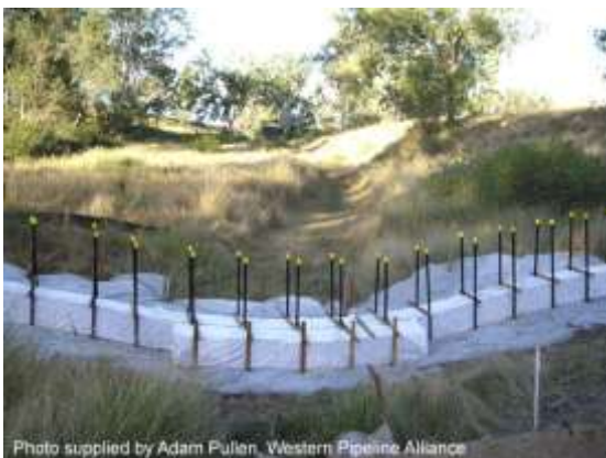
Modular sediment trap
