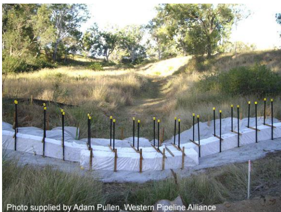
Modular sediment trap
