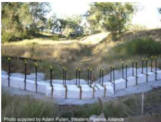
Modular sediment trap
